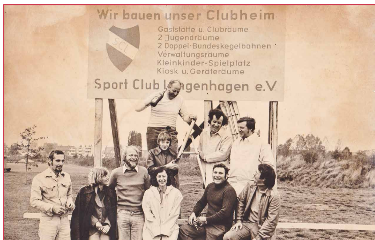
Startschuss zum Clubhaus-Neubau 1974
