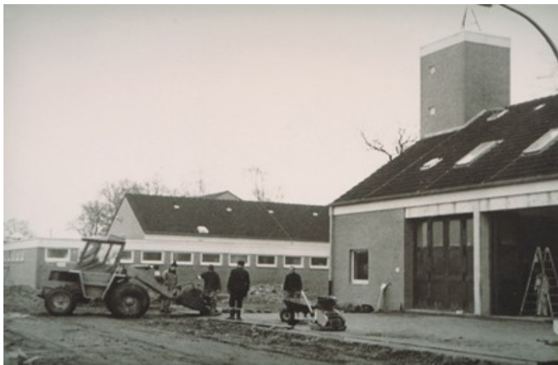
Das neue Feuerwehrgerätehaus im Bau 1967
