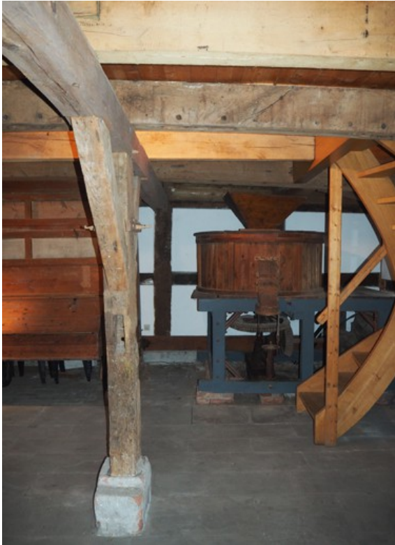
Erdgeschoss des Speichers mit der alten Mühle.
