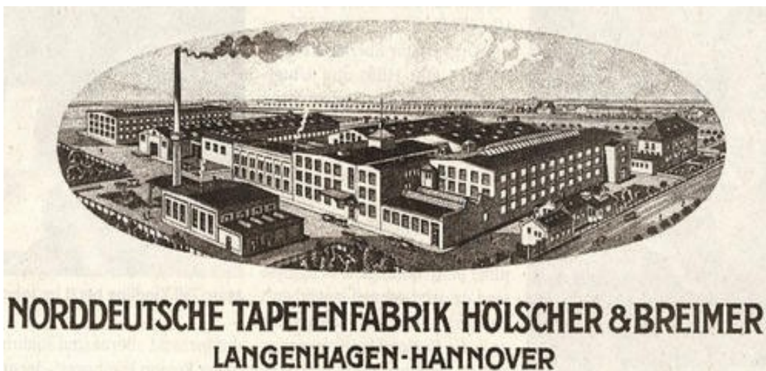
Die Situation der NORTA in den 20er Jahren, rechts die Walsroder Straße. Die auf der Grundlage des Entwurfs von Karl Siebrecht erstellten Produktionsgebäude
