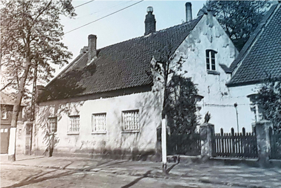
Das Färbereigebäude, das Louis Münkel im Jahr 1878 errichten ließ. Das Haus wurde später von der Firma NORTA als Verwaltungsgebäude genutzt. Mitte der 60er Jahre wurde es im Zusammenhang mit der Verbreiterung der Walsroder Straße abgebrochen.
