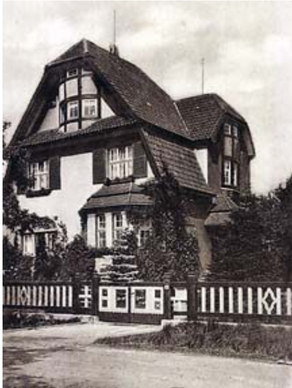
Wohnhaus Kananoherstraße Nr. 26- später Nr. 30 errichtet 1912 für Fabrikdirektor Karl Birkefeld; (im Krieg stark beschädigt)
